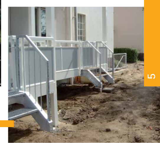
neubau balkonanlagen geeststraße
