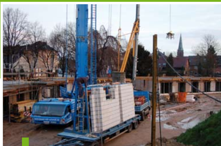
anlieferung und einbau von vorgefertigten mauerwerksteilen an der baustelle
