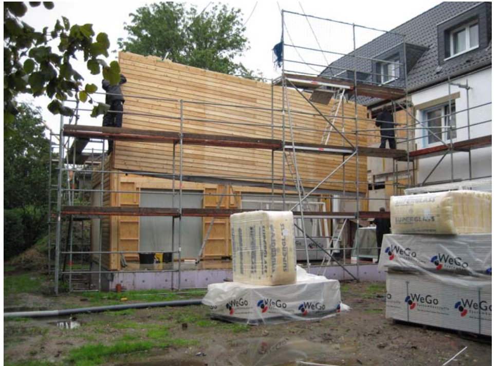
Aufbau der Anbauten
