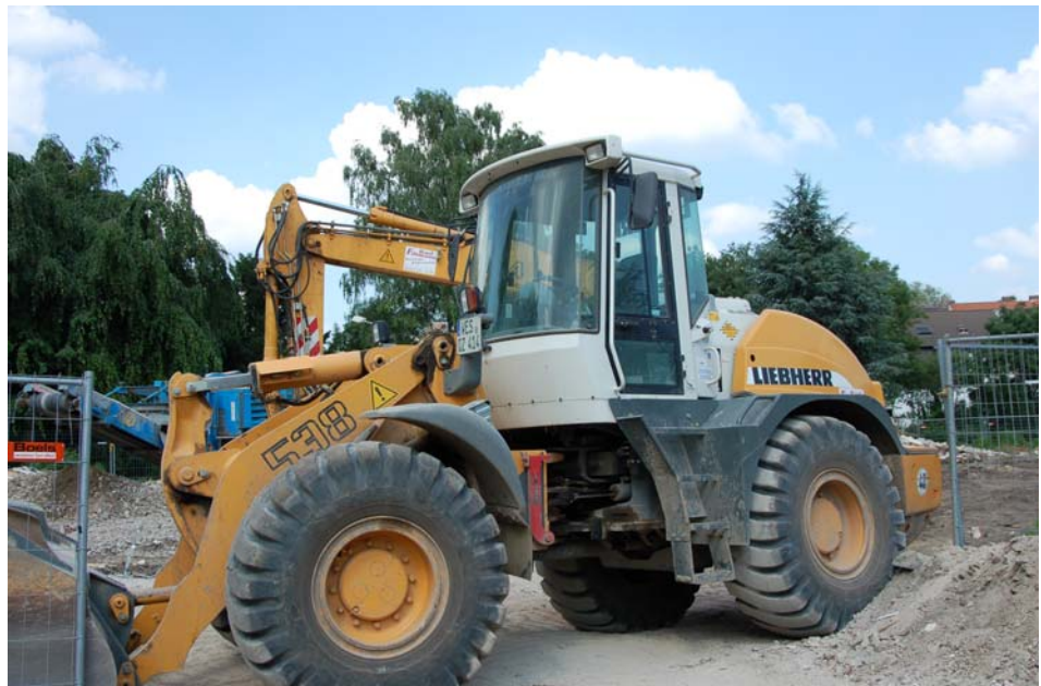
Erdarbeiten auf dem Grundstück
