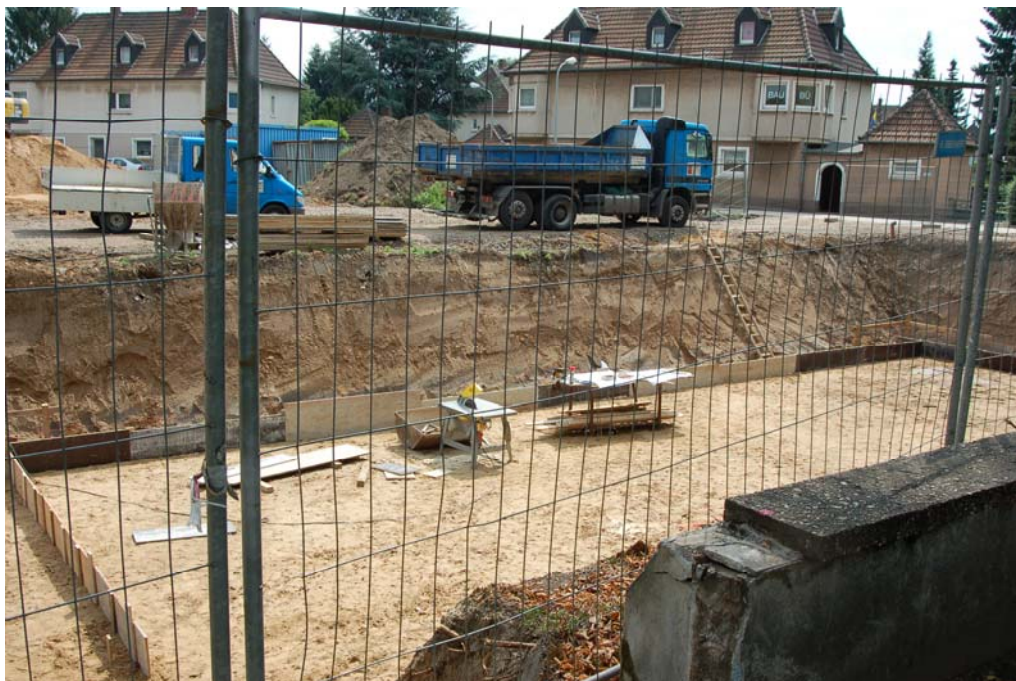
Blick in die Baugrube
