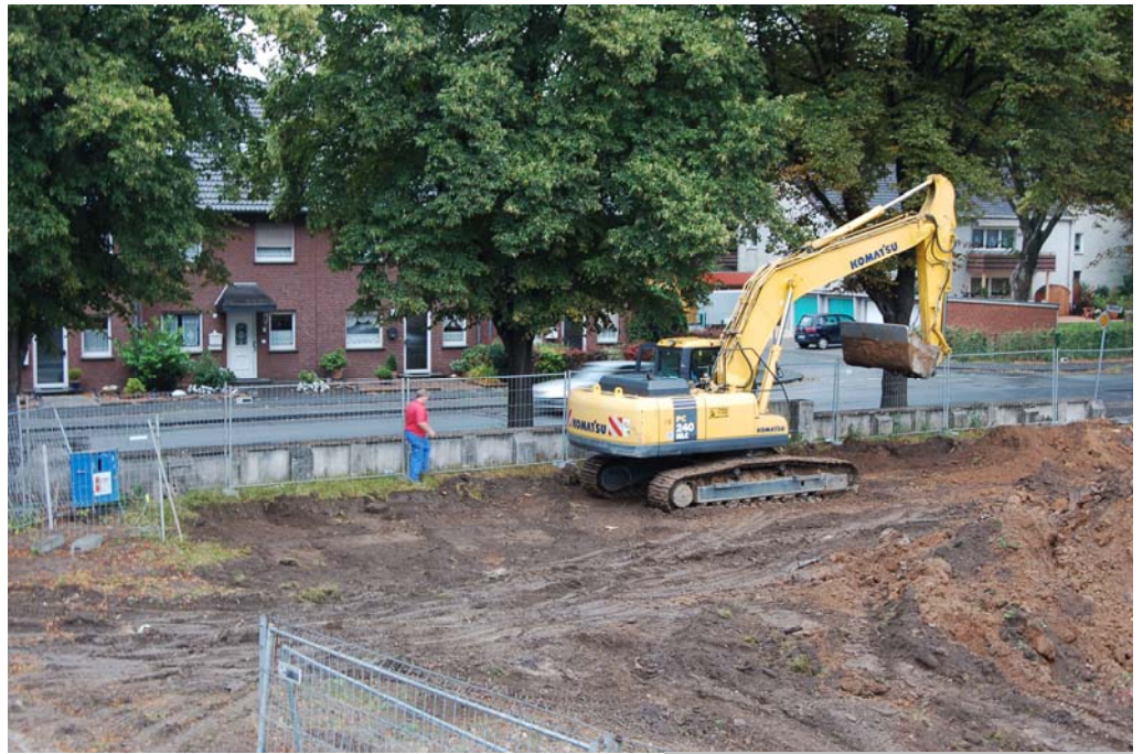
Erdarbeiten auf dem Grundstück
