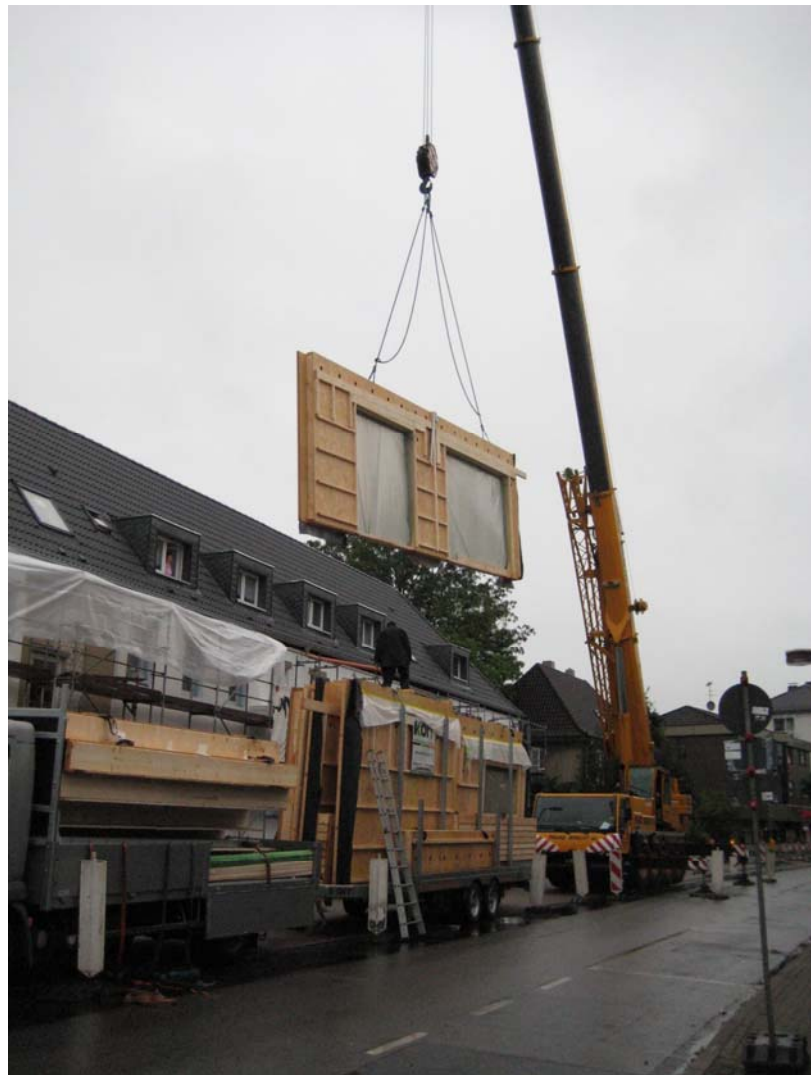
Anlieferung der Anbauten
