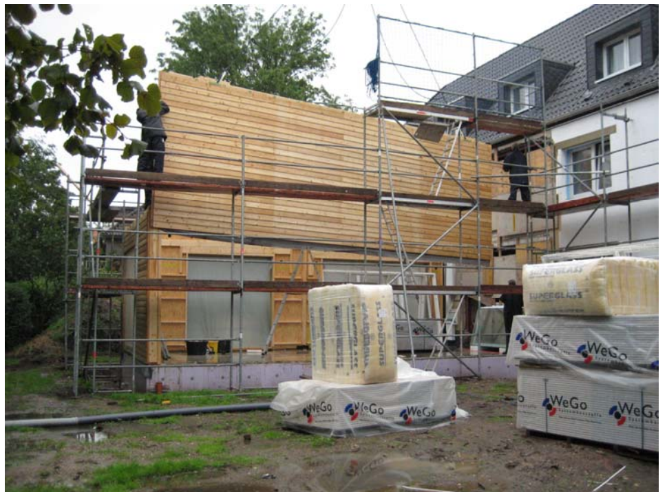
Aufbau der Anbauten
