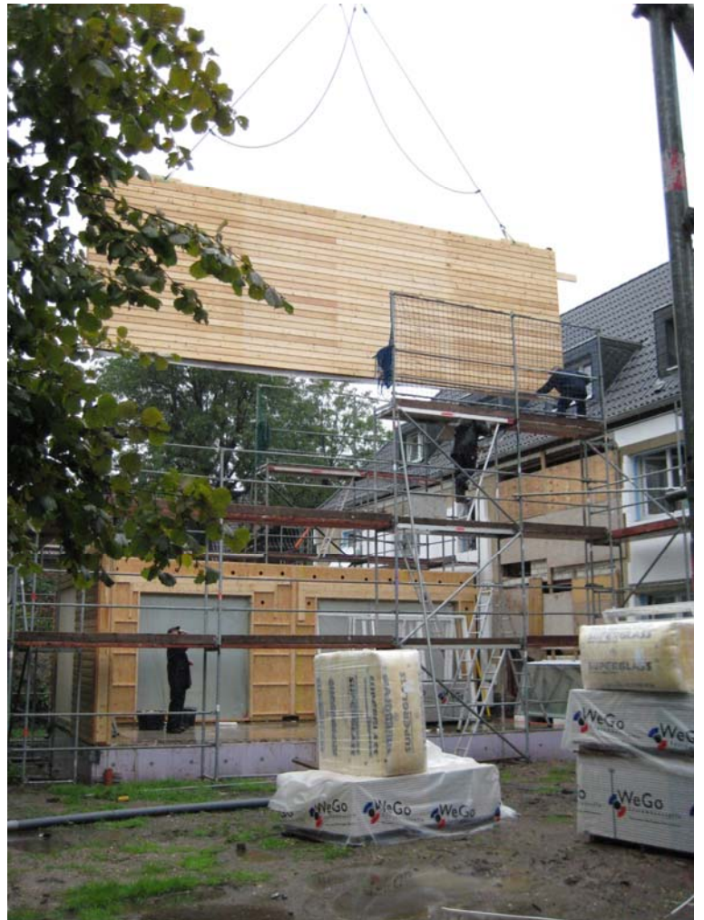
Aufbau der Anbauten
