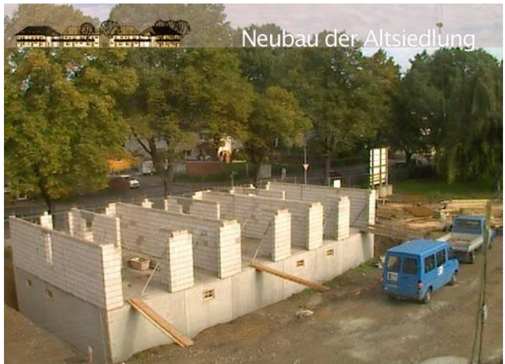
Arbeiten im Erdgeschoss
